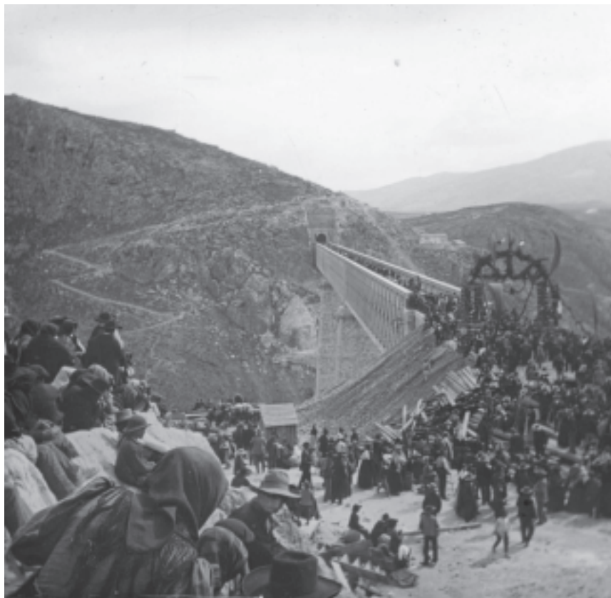
1899. Inauguración del puente sobre el río Salado.
