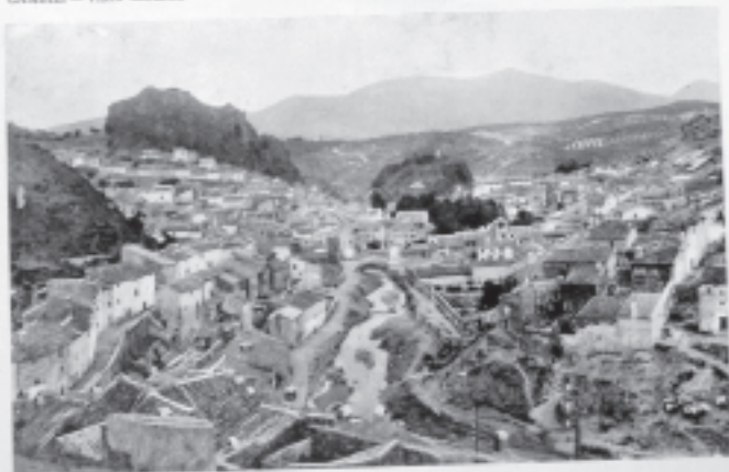
CAMBIL. — Vista general
