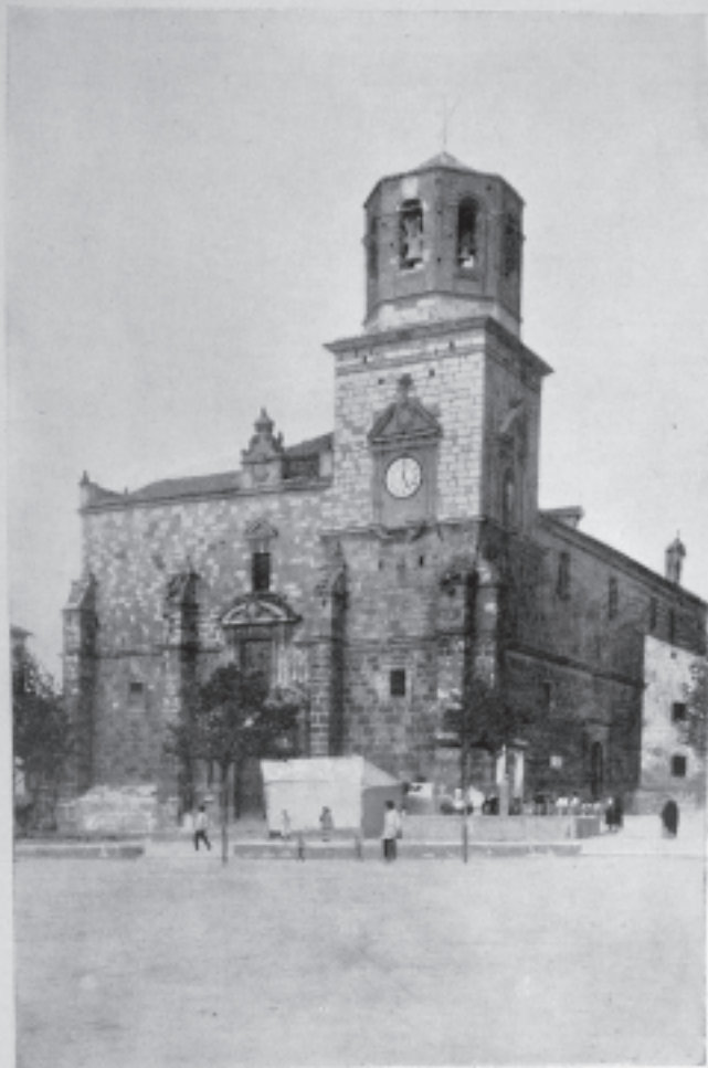
MANCHA REAL. — EXTERIOR DE LA IGLESIA PARROQUIAL
