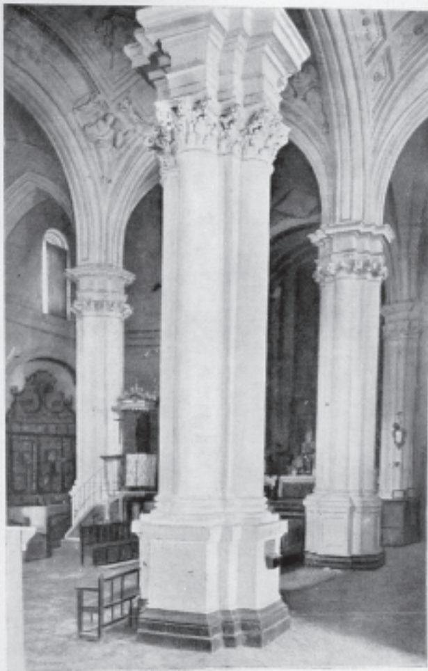
Consta de tres naves sostenidas por pilares de clásico gusto.
