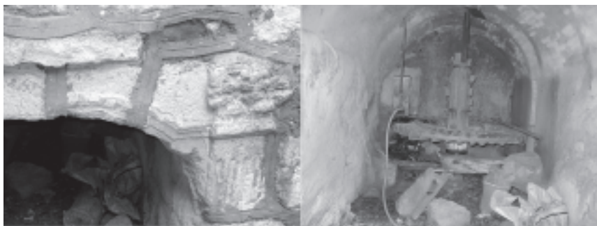
Molino El Batán. Detalle del arco de acceso donde se puede apreciar una pilastra acanalada terminada en capitel corintio. Interior donde se alojaba la piedra y el paso del agua.
