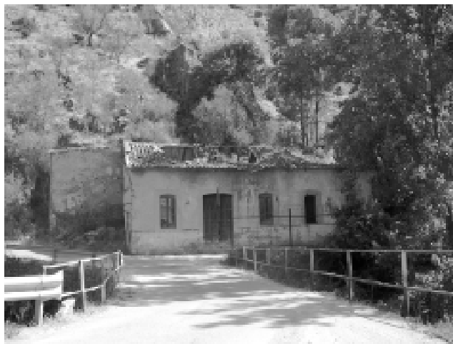
Central "Santo Domingo". Estado 2004
