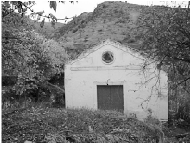
Edificio de la central Piedra Romera
