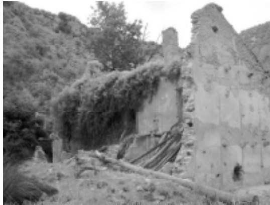
Situación actual de la central Ntra Señora de los Angeles. 2006
