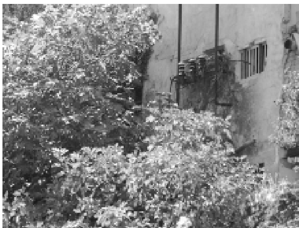
Transformador de salida de San Ildefonso
