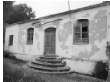
Edificio de la Central
