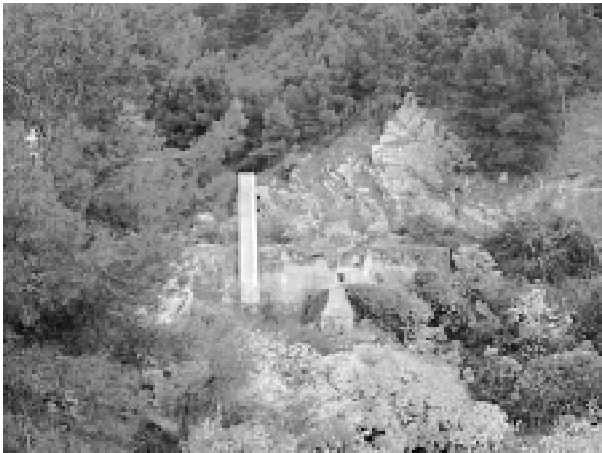
Central eléctrica de Cuadros. Primera ubicación.
