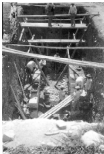
Construcción del edificio de la sala de máquinas
