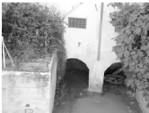
Edificio de la central. 2006
