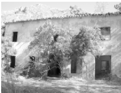
Edificio de la central
