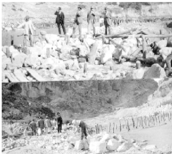
Replanteo y construcción del azud de derivación sobre el río Guadalbullón.
