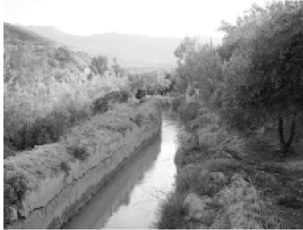
Canal de conducción. 2006
