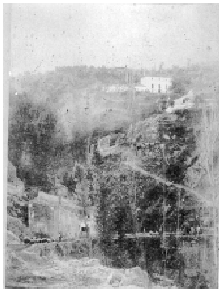
Central de San Ildefonso, parte superior derecha y “La Puente”, inferior izquierda
