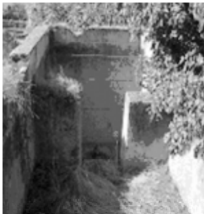
Cámara de carga
