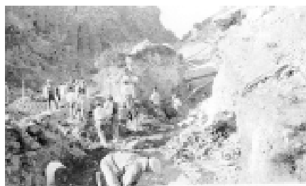
Construcción del canal
