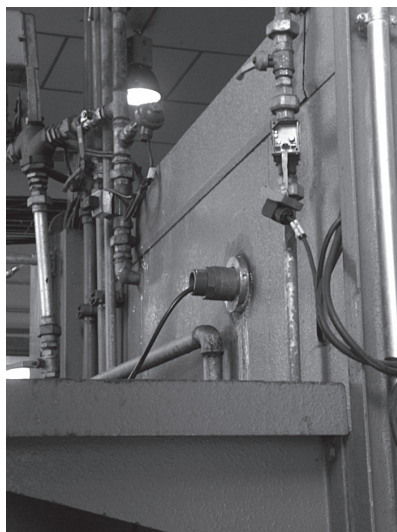
APLICACIÓN TECNOLOGÍA AOTF-NIR MULTIPLEXOR EN ALMAZARA 1. APLICACIÓN AOTF-NIR EN MASA DE ACEITUNA A LA ENTRADA DE LA BATIDORA
