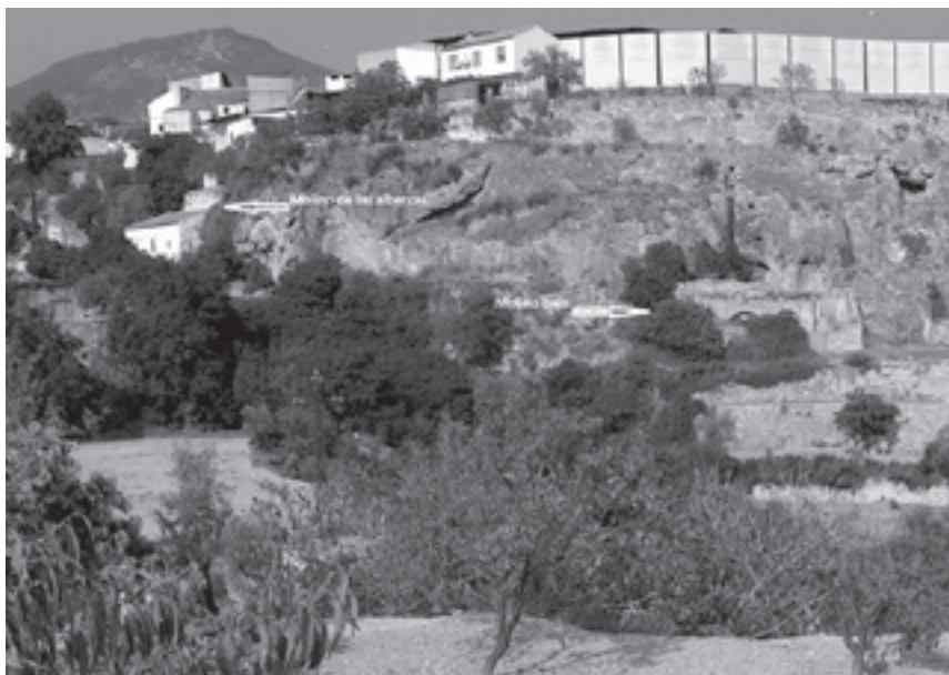
Fotografía del paraje donde se ubican los molinos de las Albercas y Bajo.
