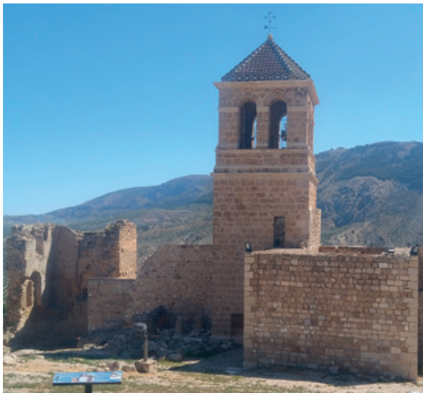
Figura 40: Torre campanario. Imagen propia
