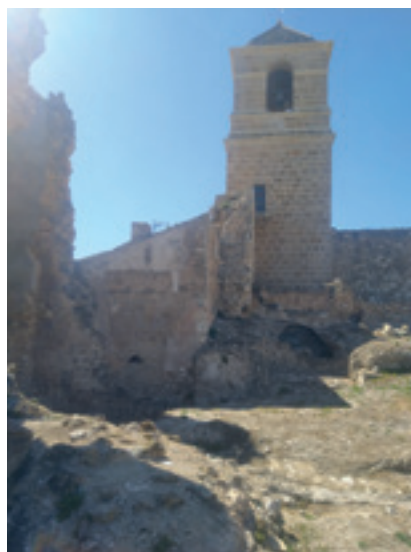
Figura 14: Torre campanario de la Iglesia de Santa María. Imagen propia.
