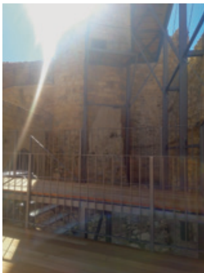
Figura 33: Pasarelas y plataformas de comunicación interior. Imagen propia
