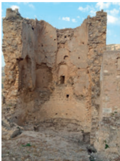
Figura 13: Iglesia de Santa María, restos del ábside. Imagen propia.
