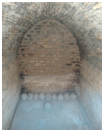
Figura 4: Aljibe restaurado. Imagen propia
